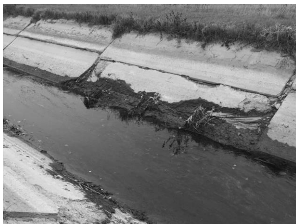
Рисунок 2 – Техническое состояние бетонной облицовки оросительного канала (фото А. Ю. Гарбуз)
