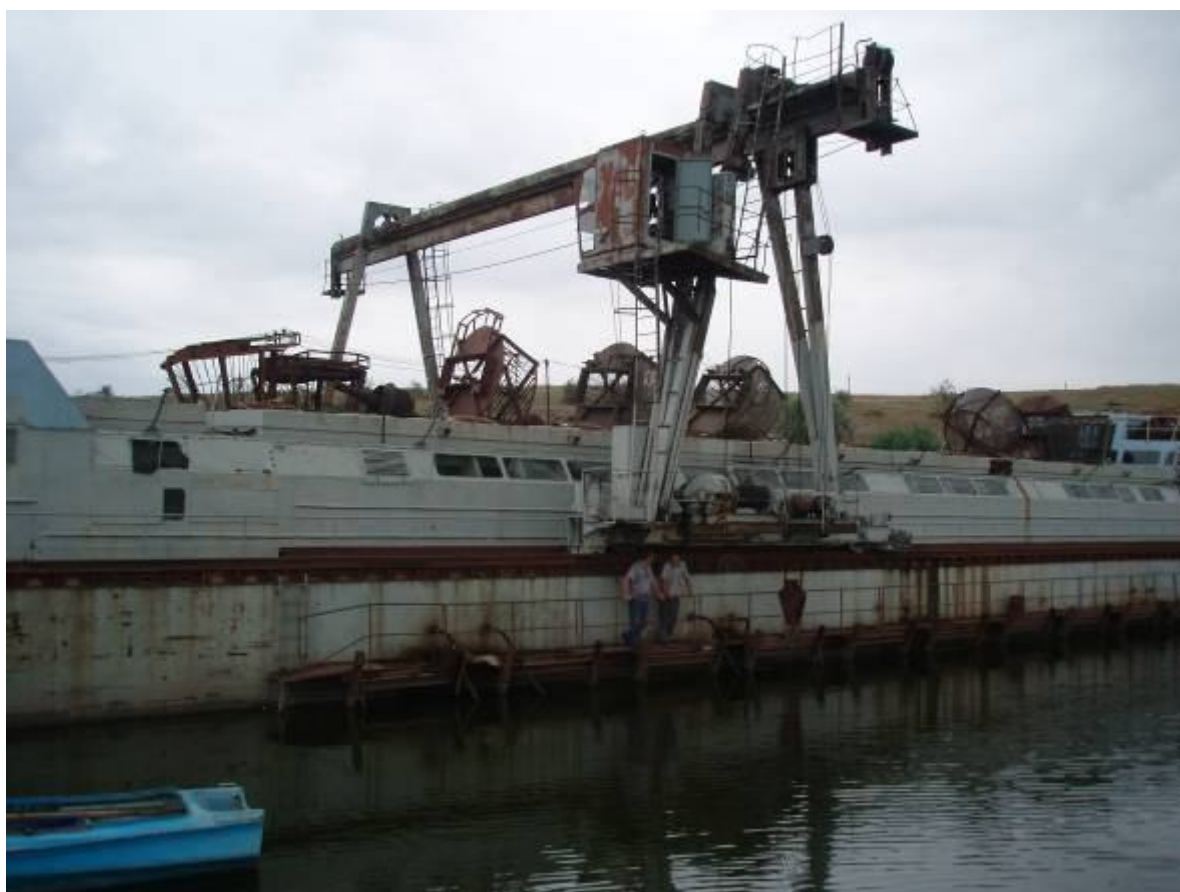
Рисунок Б.8 – Общий вид подъемно-транспортного оборудования ПНС
