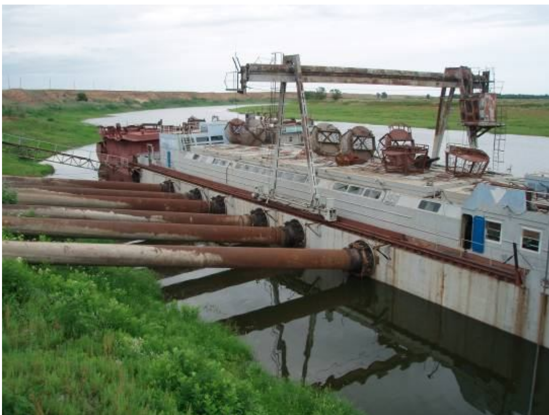
Рисунок Б.2 – Общий вид ПНС (СНР-6×1250 – 1-я станция рабочая)
