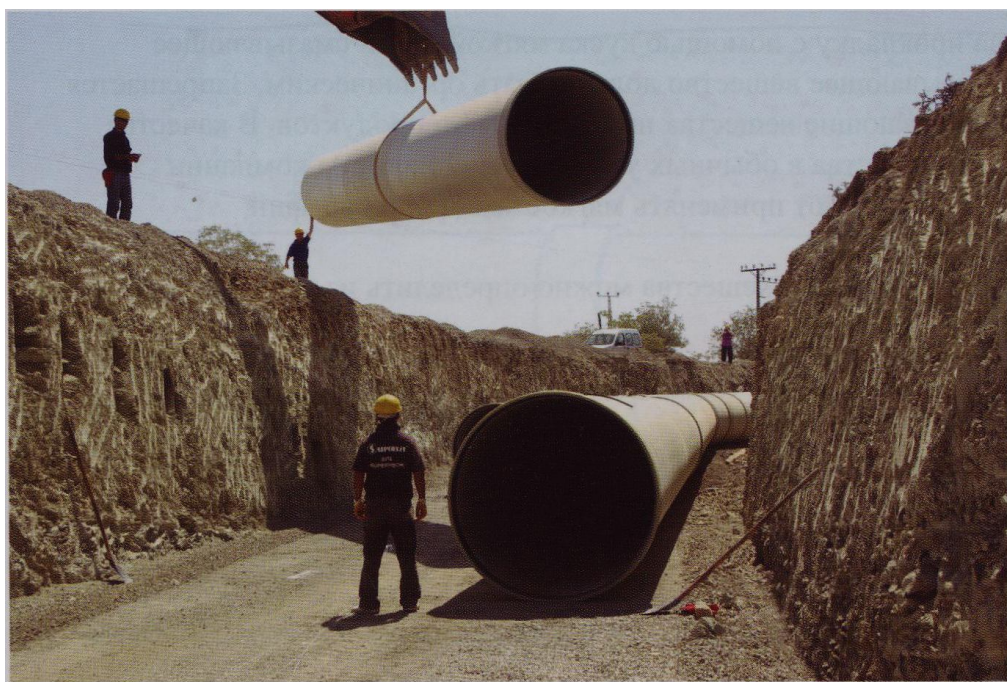
Рисунок 2 – Монтаж трубопровода из стеклопластиковых труб
